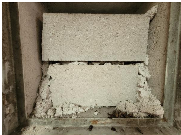
Figure 8 : Zoom sur une fenêtre obstruée avec des parpaings / Figure 9 : Cavité au sein des parpaings présentant du guano à leur base
