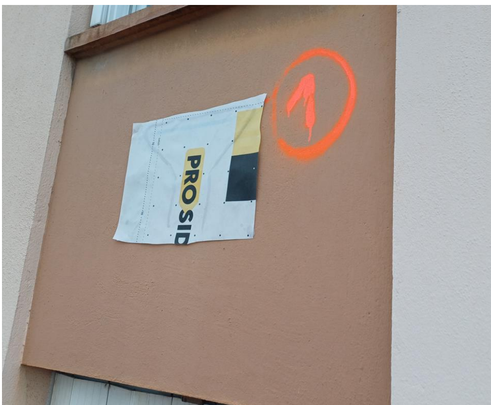
Figure 11 : Exemple de matériaux mis en place pour réaliser un système anti-retour
